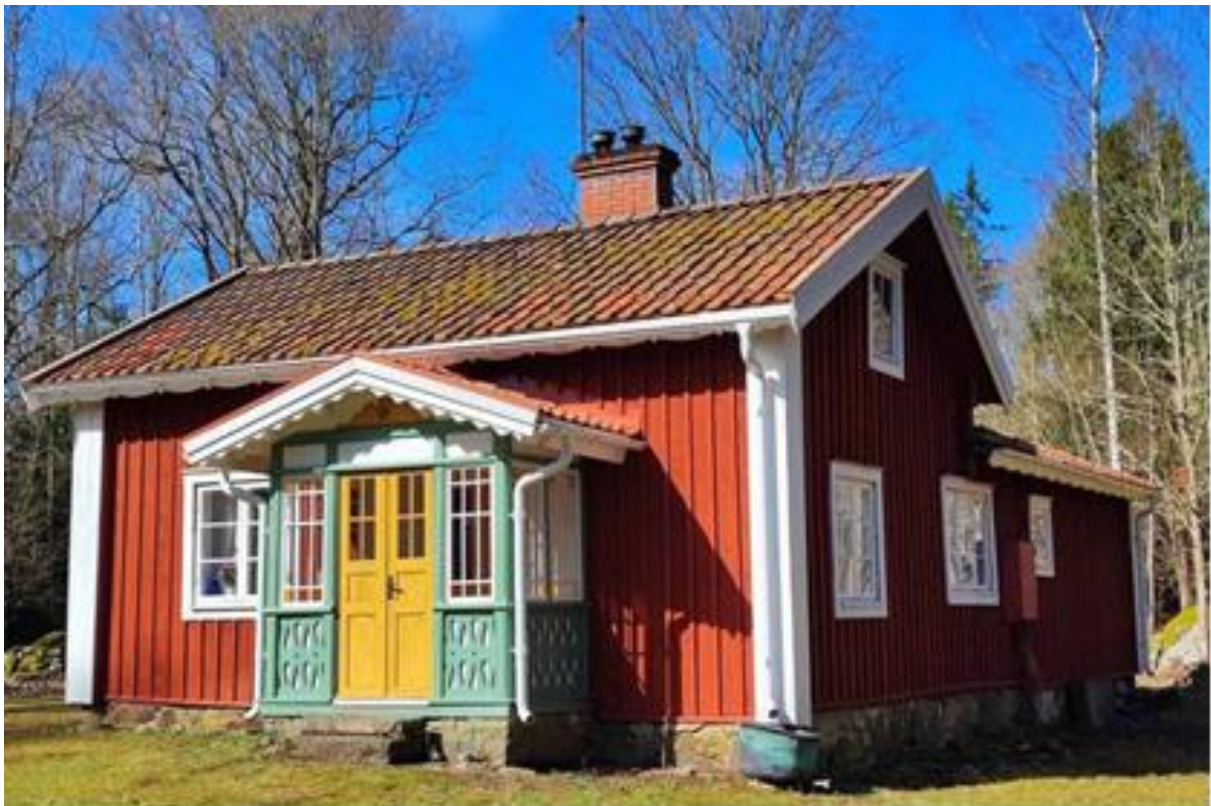
Hagstad Norratorp efter tillbyggnad (bild från 2024)
