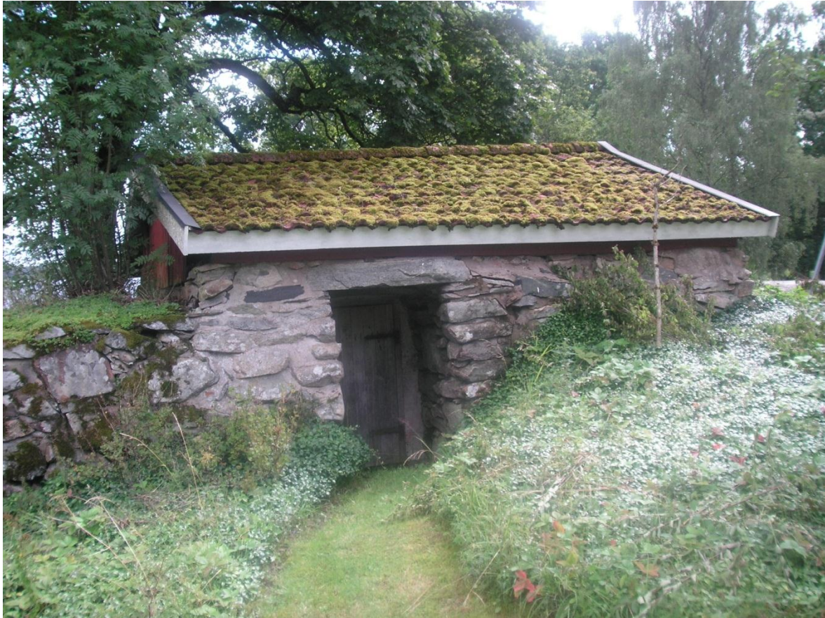
Stenkällaren i Hallen. Foto 2007 av Ingolf Berg.
