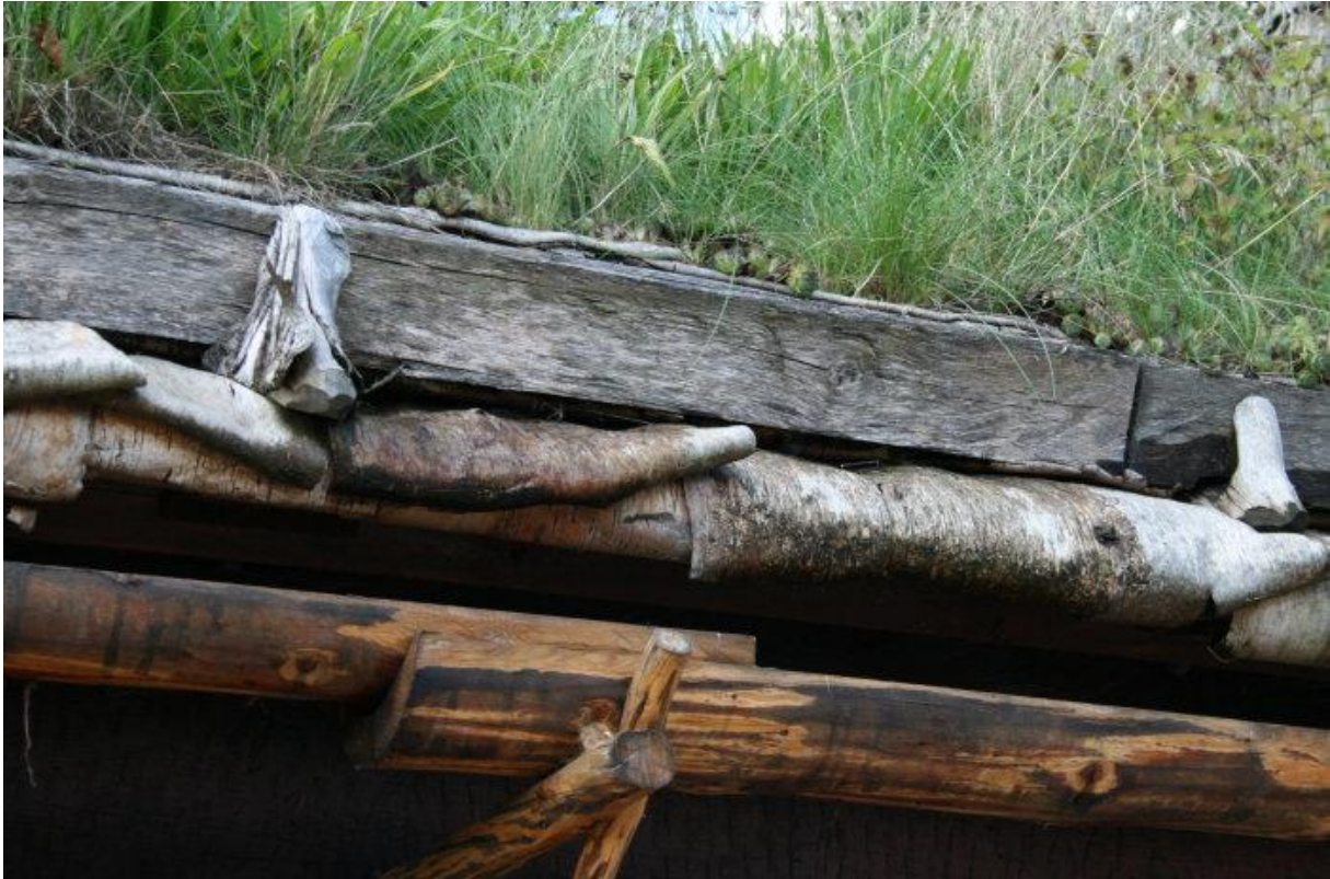
Takfot med näver och torv.
