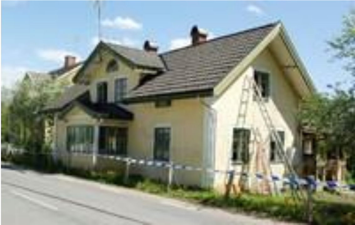
Det äldsta huset i Torne, efter brand – se sid 17. Ersatt med ny byggnad i holländsk stil.
