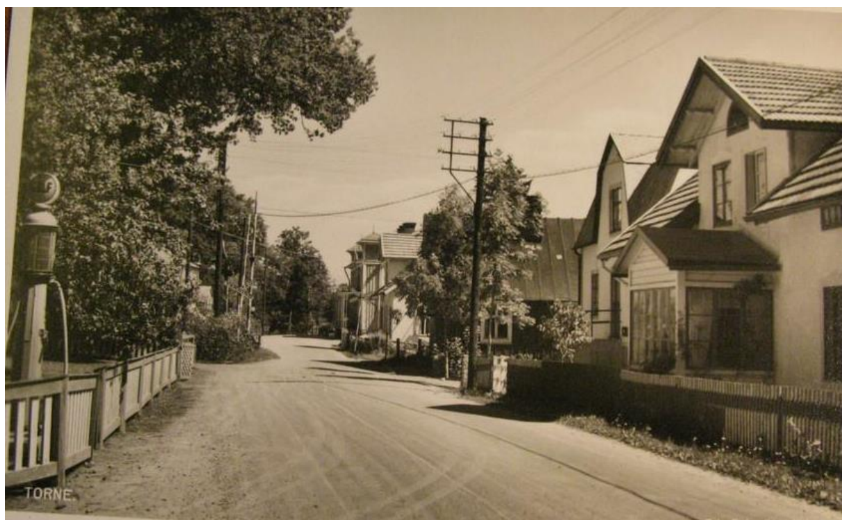
Torne samhälle med Gulf bensinstation och längre fram järnvägs korsningen med bommar. Ruth Möllers hus i fonden med glasverandan brann upp på 2010-talet, en tragedi då en ung ensamstående mamma tände eld på sig själv och huset brann ned. Det var Tornes äldsta hus, En holländare har på platsen byggt ett nytt hus i traditionell holländsk stil. Där Gulftappen står fann bilskola med stort garage, Ströbergs lanthandel sålde inte bensin då. Vykort troligen 1940-tal.
