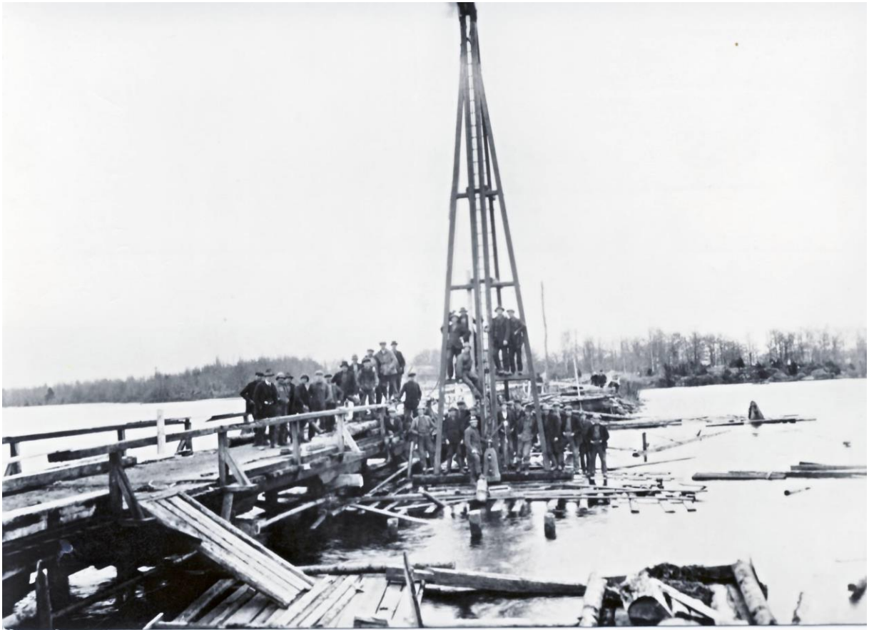
Pålningsarbete vid uppförande av Torne bro (vykort 1883)
