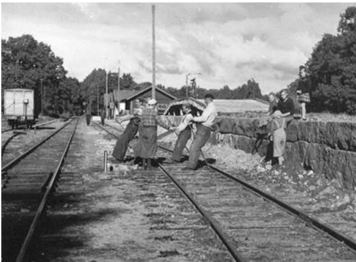
Arbete med järnvägrälsen vid Torne station. Stationen skymd av den magasinsbyggnad som bortforslades vid nedläggningen av järnvägen.
