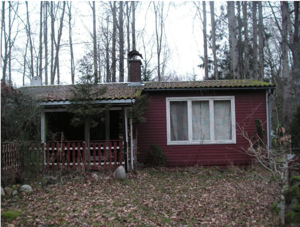
Den första sommarstugan i Hagstad uppfördes 1965 av snickare från Grimslöv. Det var ett typhus från Västkuksstugan, senare tillbyggt med uteplats under tak på framsidan.
