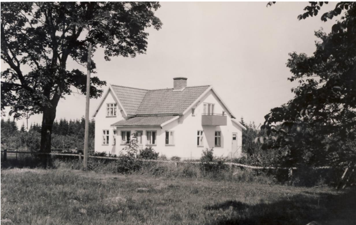
Hagstad Norregård efter omfattande renovering och revetering av ytterväggar år 1951. Huset försågs bl.a. med centralvärme och badrum i källarplanet.
